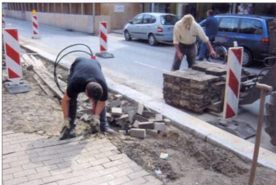
Pflasterarbeiten vor Sunkten Foto: Martin Glandorf
